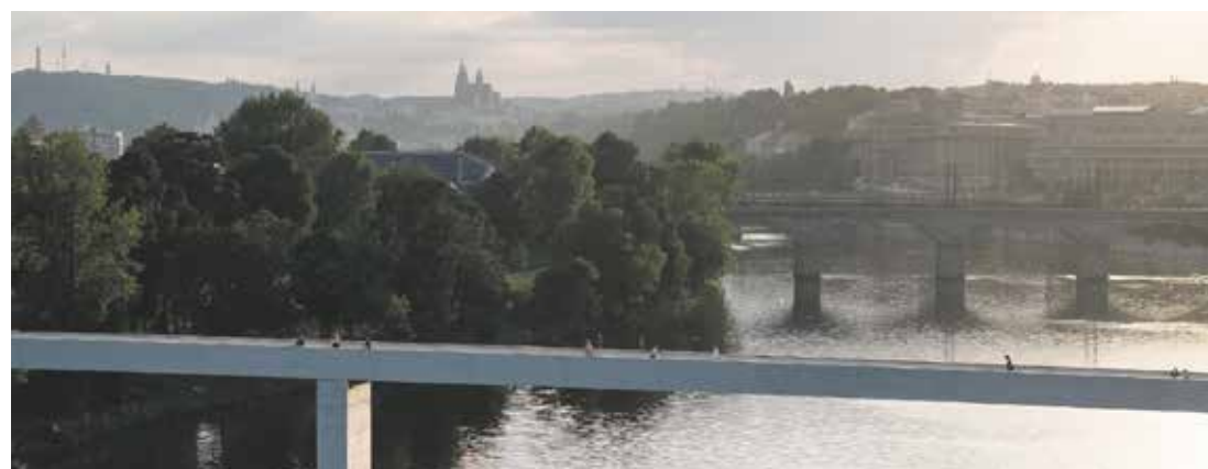
Zatím v žádném případě nebyl použit ultra vysocehodnotný beton na tak velké stavbě, navíc v bílé barvě. Foto | IPR Praha
