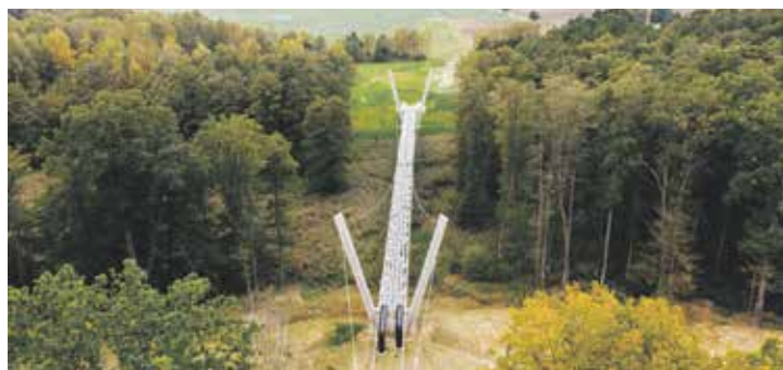
Horkovod vede pod zemí. Na třech místech přes přírodní biotop Křivonoska a dvakrát v Hluboké nad Vltavou vystupuje na povrch. Foto | ČEZ
